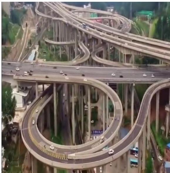
Najbardziej skomplikowany węzeł drogowy ma 5 poziomów i ok. 20 ramp. Znajduje się on w dystrykcie Nan'an w Chinach, i łączy w sobie drogi w ośmiu kierunkach.
