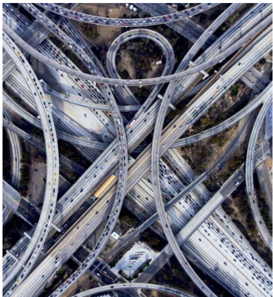
Największy węzeł drogowy w Los Angeles, USA nazwany imieniem sędziego Harry'ego Pregersona. To skrzyżowanie dróg stanowych, które składa się aż z 5 poziomów.
